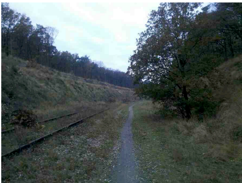
Figuur 2. De spoorkuil aan de noordzijde van de fietsbrug kijkend richting de Biesseltsebaan. Aan de linkerkant ligt snoeiafval op de rails.
